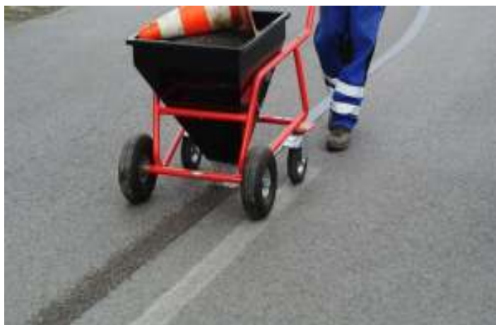
Posyp tříděným kamenivem 2/5 – posypový vozík Bitrak PV, 29.5.2013, Marcelová, SK
