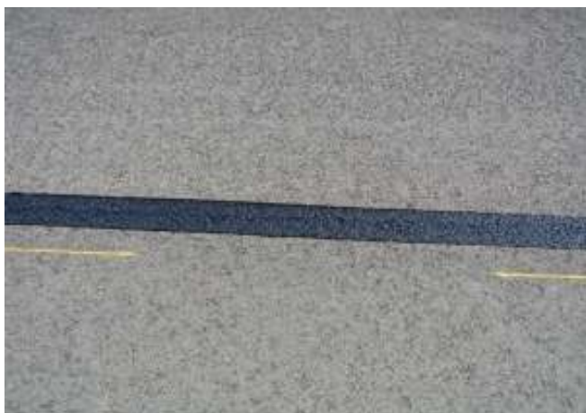
Detail ošetření Rissflexem – obec Marcelová, SK, 29.5.2013
