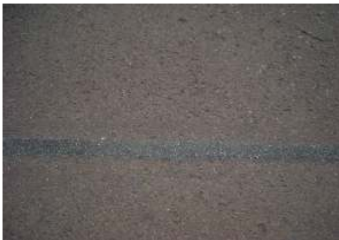
Ošetřená spára – mírné převýšení nad úroveň vozovky
