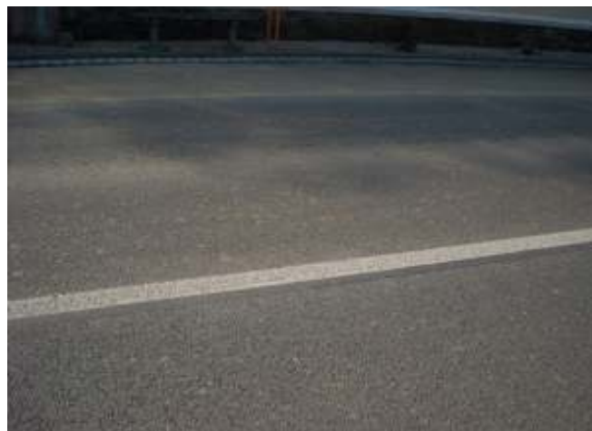
Spára ošetřená Rissflexem po 3 zimách Zárybničná Lhota
