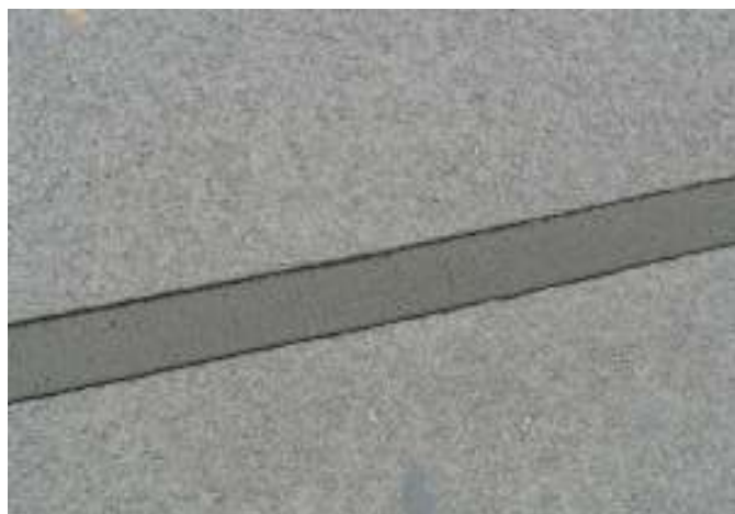
Detail ošetření Rissflexem – obec Marcelová. SK. 29.5.2013
