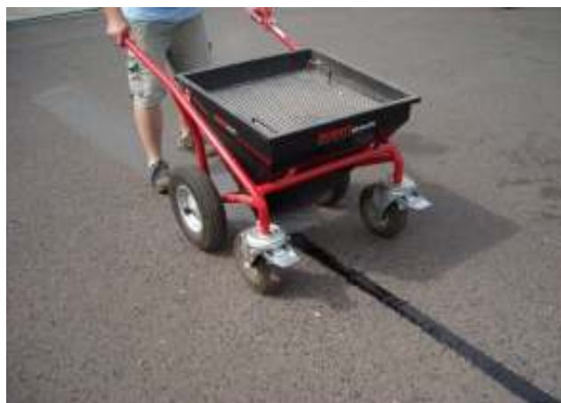
Zasypání spáry s využitím sypacího vozíku
