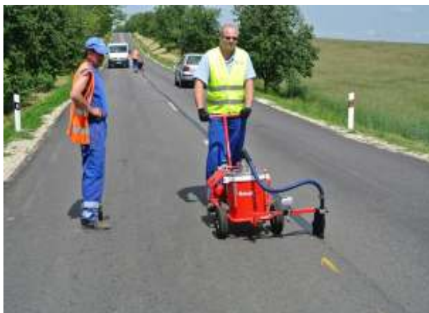
Ošetření spáry Rissflexem – 29.5.2013 – silnice 2. tř. Marcelová – Bátorové Kosihy, SK
