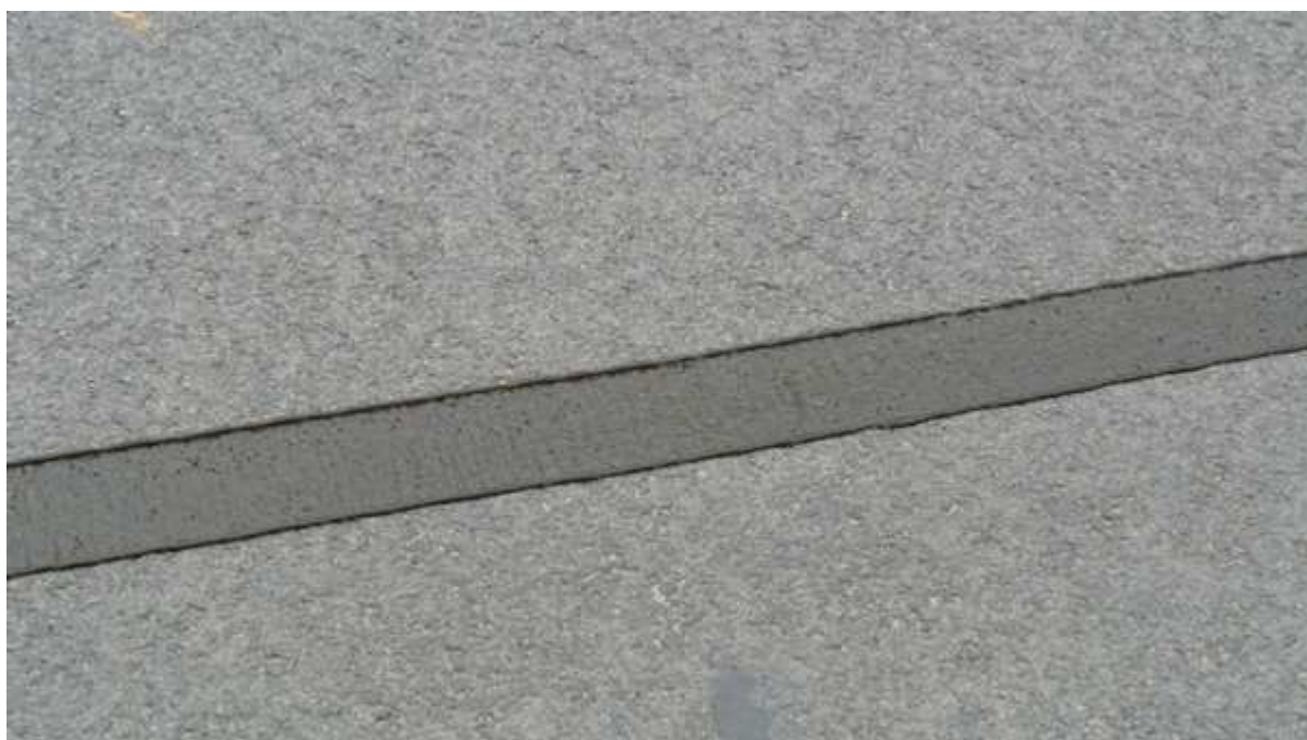
Detail ošetření Rissflexem – obec Marcelová, SK, 29.5.2013
