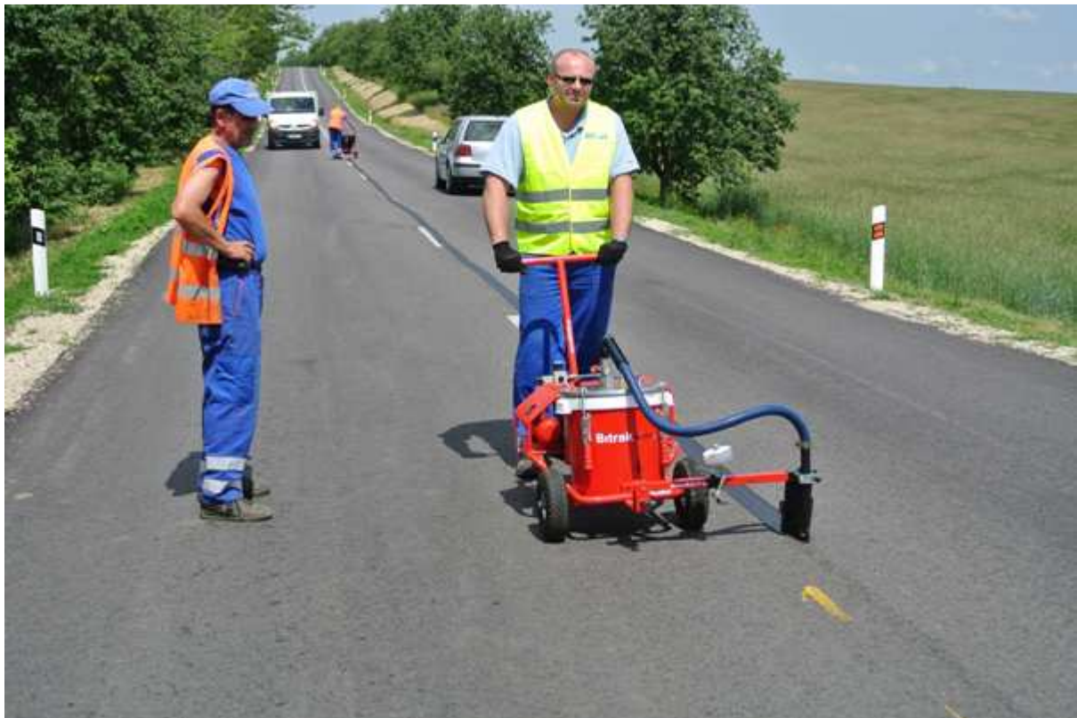
Ošetření spáry Rissflexem – 29.5.2013 – silnice 2. tř. Marcelová – Bátorové Kosihy, SK
