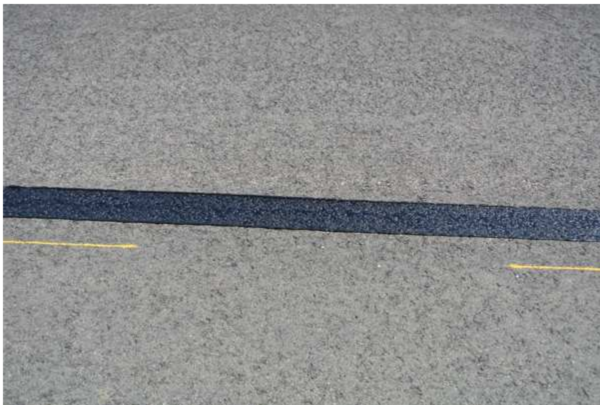
Detail ošetření Rissflexem – obec Marcelová, SK, 29.5.2013
