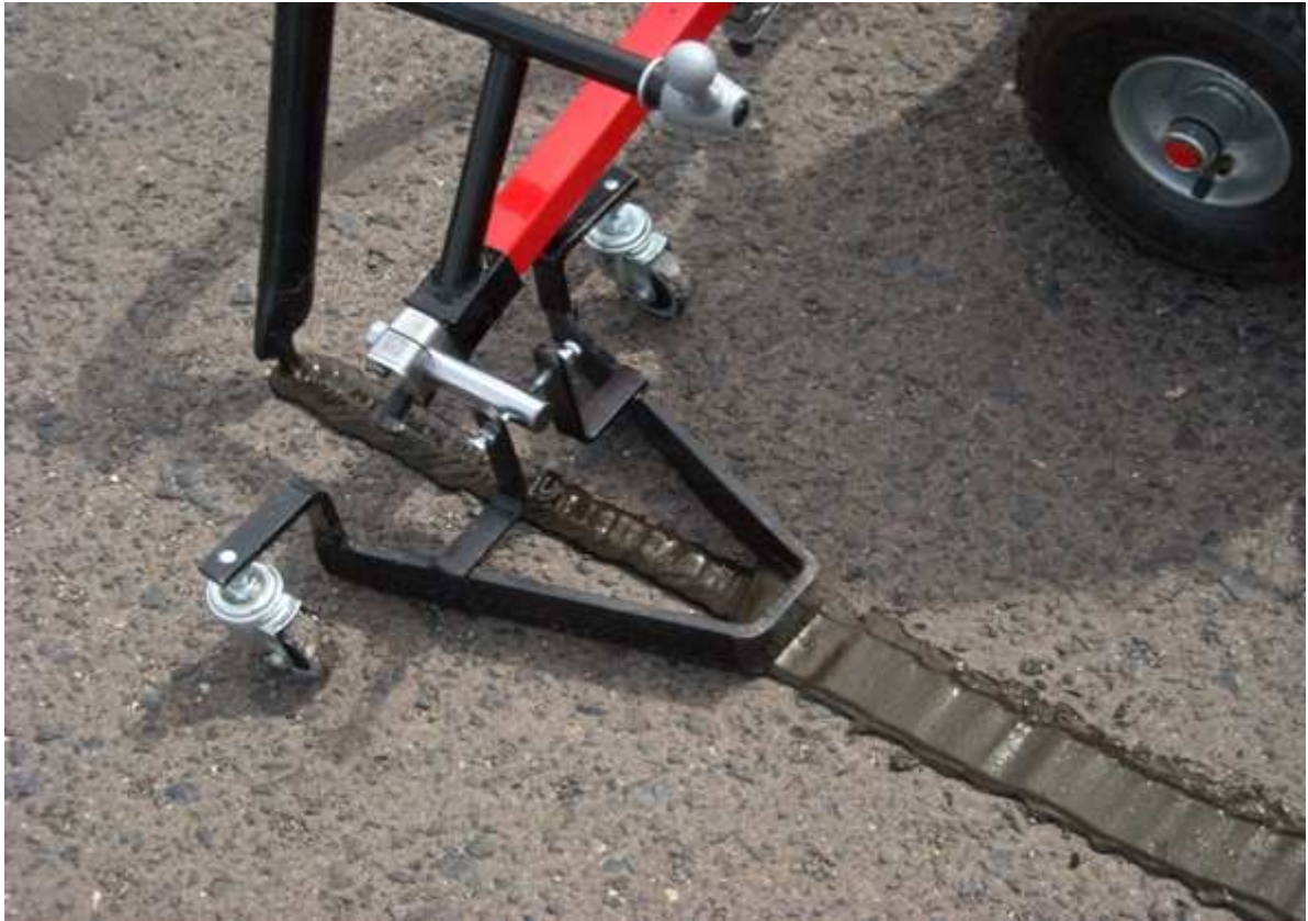
Ilustrační foto – použití stahovací botičky
