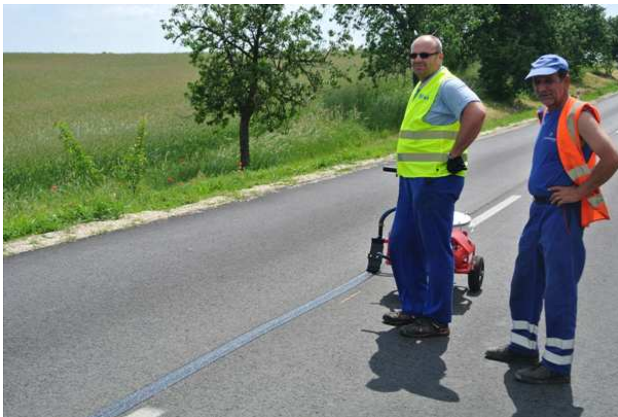
Silnice 2 tř. Marcelová – Bátorové Kosihy, SK, 29.5.2013
