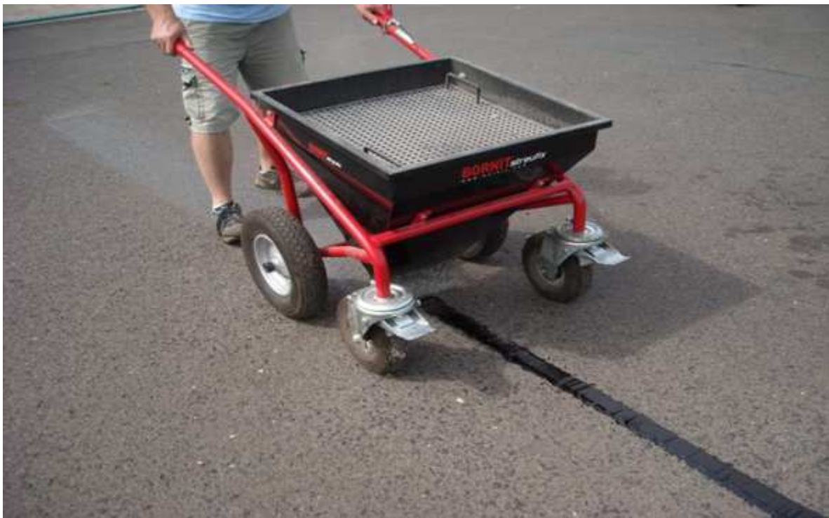
Zasypání spáry s využitím sypacího vozíku Bornit Steufix
