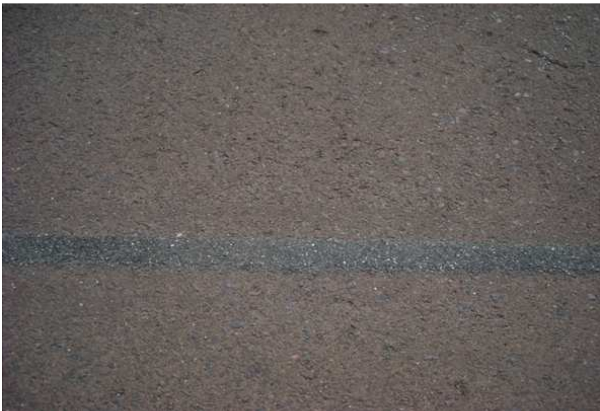
Ošetřená spára – mírné převýšení nad úrovní vozovky
