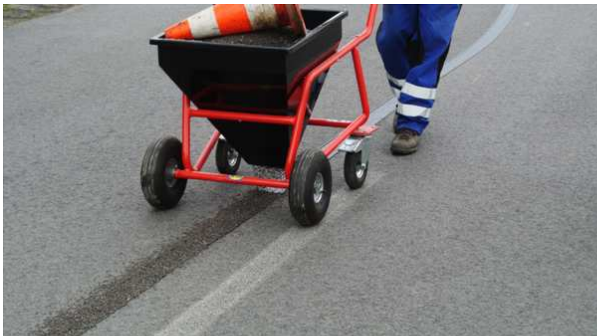
Posyp tříděným kamenivem 2/5 – posypový vozík Bitrak PV, 29.5.2013, Marcelová, SK
