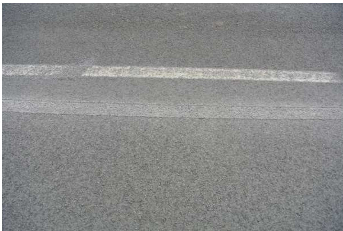
Ošetřená spára vč. zasypání kamenivem po 3 hod., 29.5.2013, Marcelová, SK, teplota 24°C
